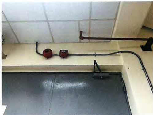
ภาพที่ 2.2-52 ระบบเสียงสัญญาณเตือนภัย
