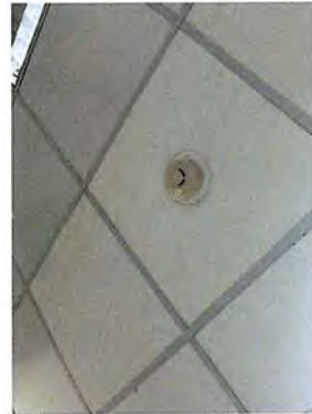
ภาพที่ 2.2-53 Smoke Detection
