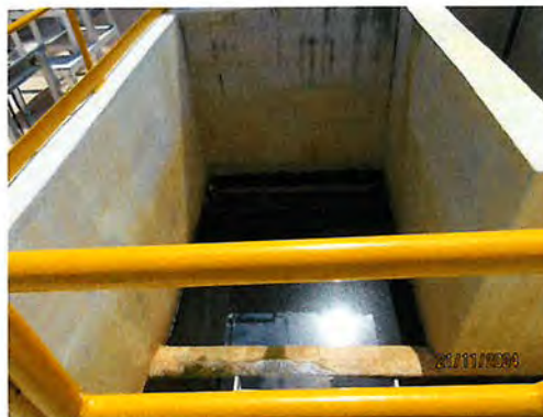
ภาพที่ 2.2-20 Oil Separator Tank ขนาดในการบำบัด 40 ลูกบาศก์เมตร
