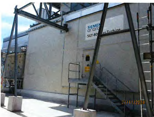
ภาพที่ 2.2-26 อุปกรณ์ลดเสียง (Enclosure)
