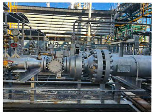
ภาพที่ 2.2-59 วาล์วควบคุม 2 ชั้น ในระบบก๊าซ NG
