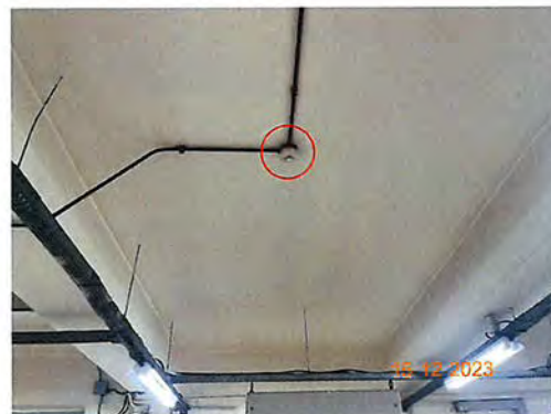
ภาพที่ 2.2-54 Heat Detection
