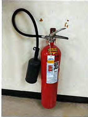
ภาพที่ 2.2-56 อุปกรณ์ดับเพลิง ชนิด CO 2
