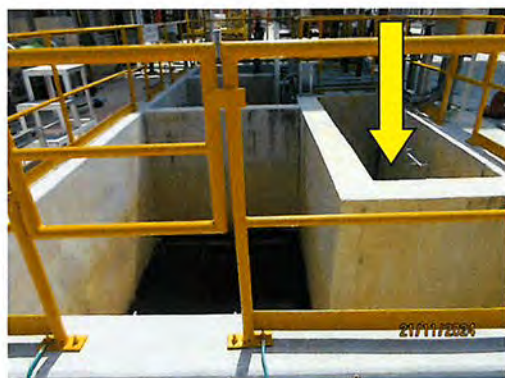
ภาพที่ 2.2-21 Oil Separator Tank ขนาดในการบำบัด 14 ลูกบาศก์เมตร
