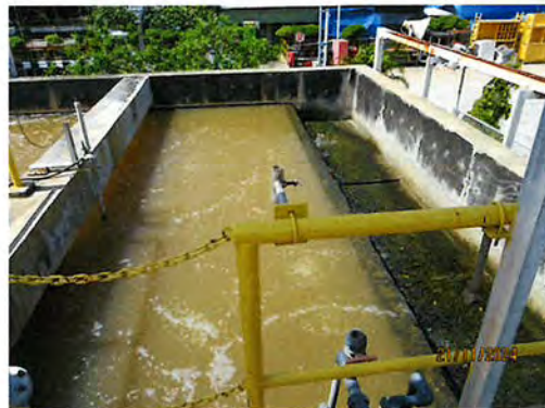
ภาพที่ 2.1-16 บ่อปรับสภาพน้ำเสีย (Neutralization)
