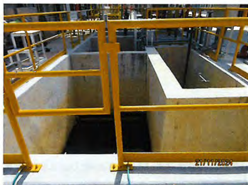
ภาพที่ 2.2-18 ระบบแยกน้ำมันปนเปื้อนออกจากน้ำเสีย
